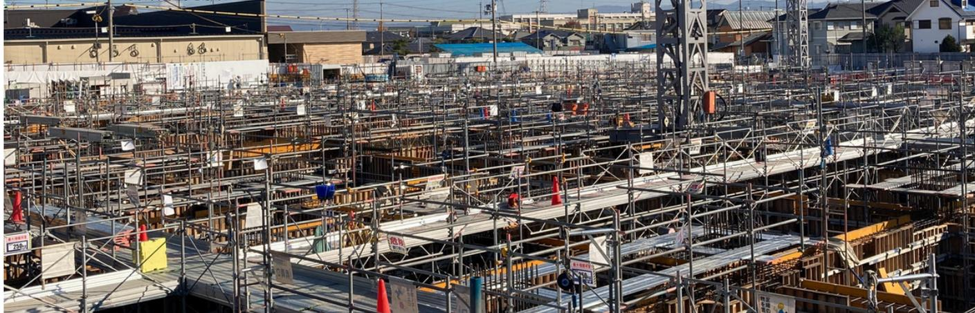
杭168本の打設を完了し、掘削工事では約41,000m<sup>3</sup>の土砂を搬出しました。これに伴い、東側エリアでは躯体工事の準備作業を進めています。また、建物全体の約2/3において基礎地中梁の躯体工事が開始されています。
